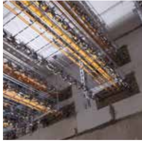
Montage avant chauffe
